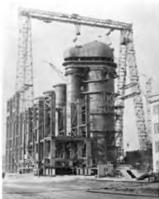
Рис.13.17. Воздухонагреватель с выносной камерой горения
