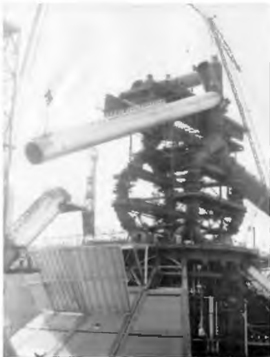
Рис.13.12 Бескопровое колошниковое устройство
