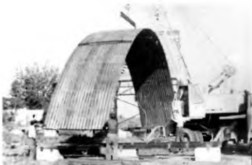
Рис.11.17. Монтаж здания «Волна-360»
