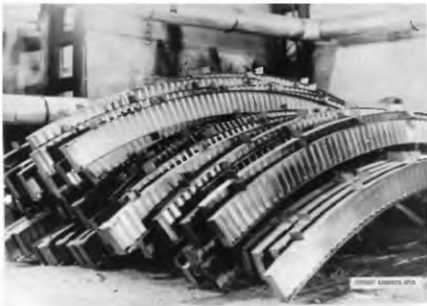
Рис.11.12. Полуцилиндрические покрытия с каркасом из арок вверху - общий вид монтажа каркаса; внизу - элементы арок с гофрированной стенкой
