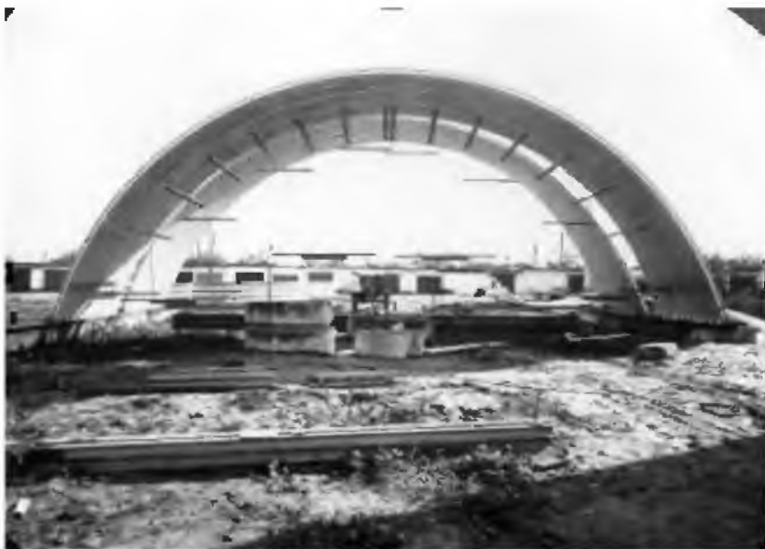
Рис.11.19. Бескаркасное здание из гнутых профилей: однослойные фрагменты покрытия во время испытания
