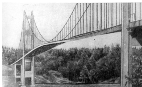
Деформация крутильных колебаний Такомакого моста приблизительно за час до крушения (США, 1940 г.)
